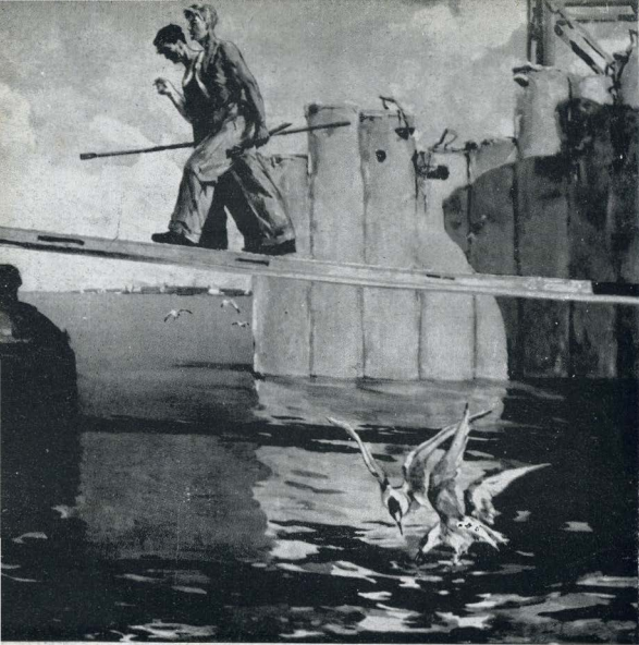
Строители нового порта.
