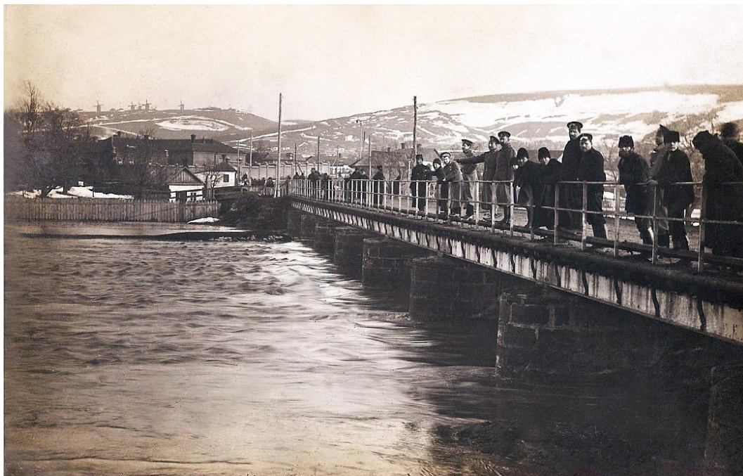
Початок XX століття. Кам'яний міст через річку Тилігул. Фото зроблене під час весняного паводку, коли річка розливалася дуже широко, іноді підтоплюючи нижню частину міста. Фото з фондів історико-художнього музею Ананьєва.
