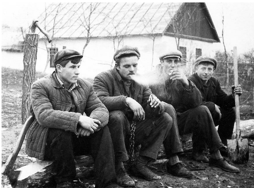
Короткий відпочинок. Бригада електриків Ананьївської "Сільелектро".
