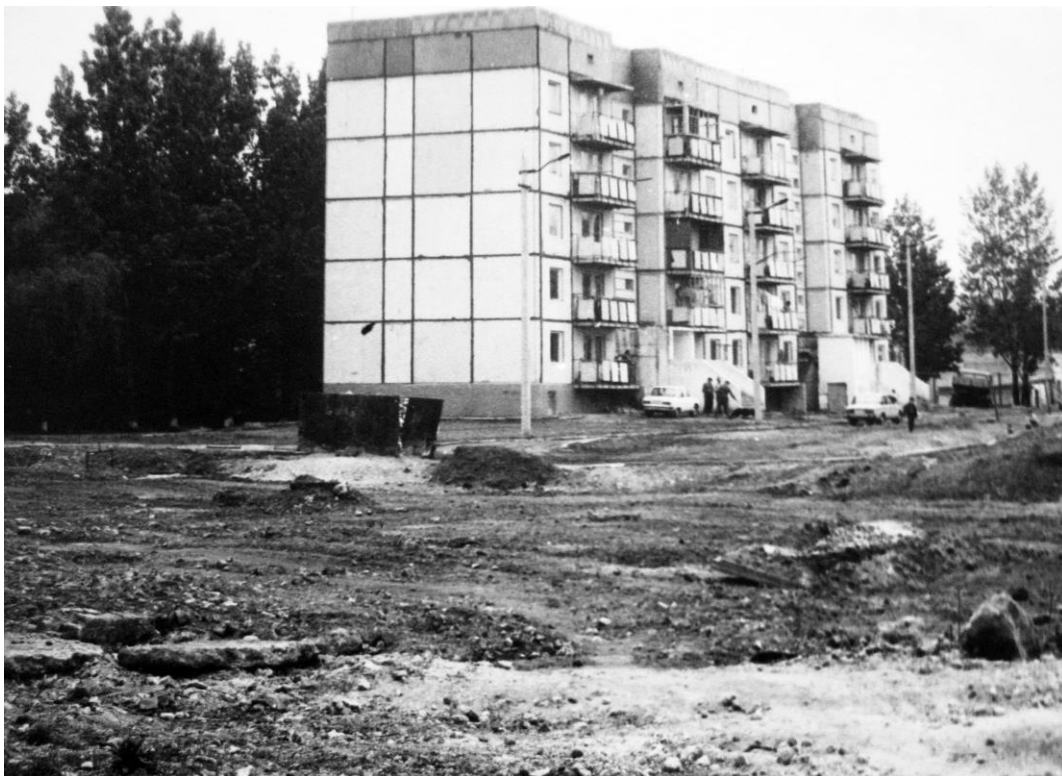
Будівництво п'ятиповерхового будинку на розі вулиць Незалежності та Пушкіна.
